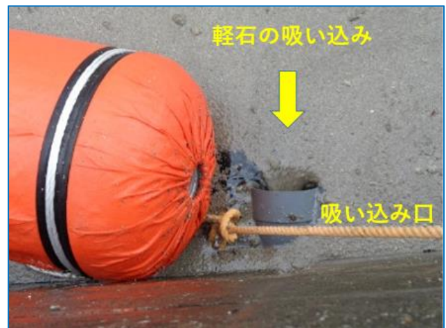
軽石の吸い込み
